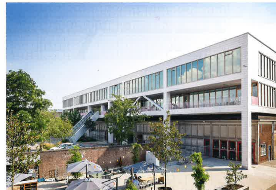
Het grote balkon op de eerste verdieping verbindt de nieuwbouw met de omgeving.
