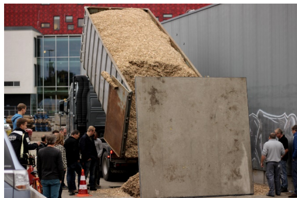
Het hout wordt opgeslagen in de naastgelegen kelder.
