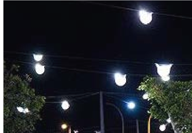
Opspannen verlichting tussen omringende bebouwing boven stegen*
