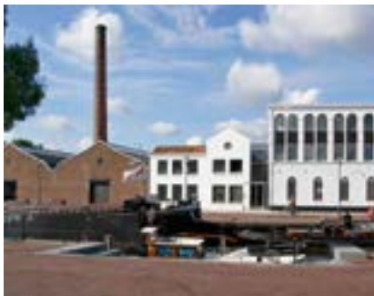
Voormalige zeepfabriek Rohm&Haas en buitenplaats Eemzicht
