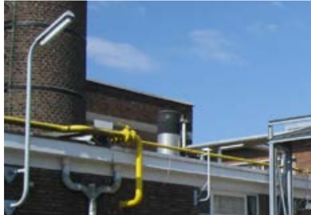
Bevestigen verlichting aan omringende bebouwing bij straten*
